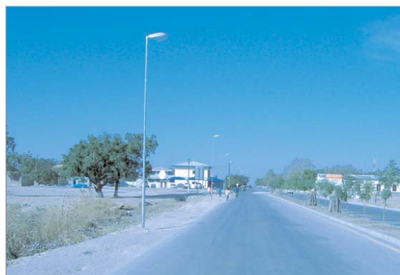
Figura 6.4 - Iluminação Pública Nova na Avenida 11 de Novembro.
