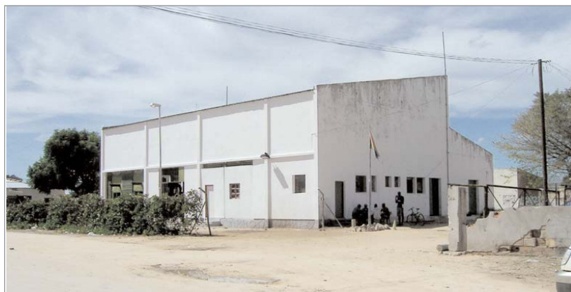
Figura 6.1 - Substação de Ondjiva.
