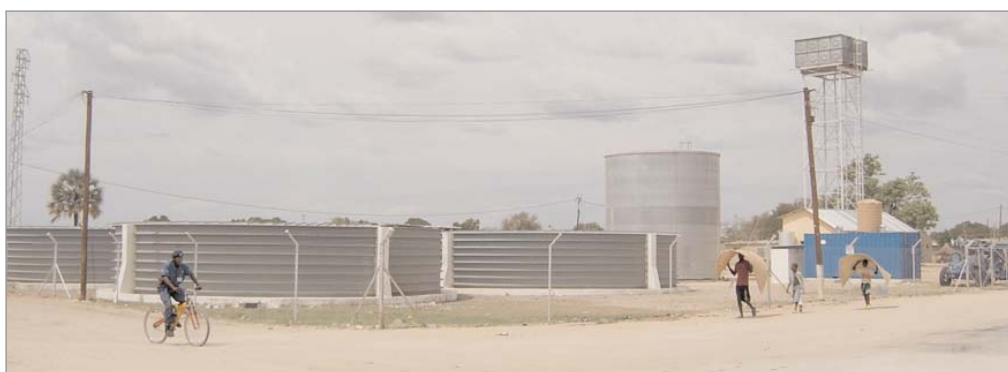
Figura 2.4 - Centro de Distribuição Principal.
